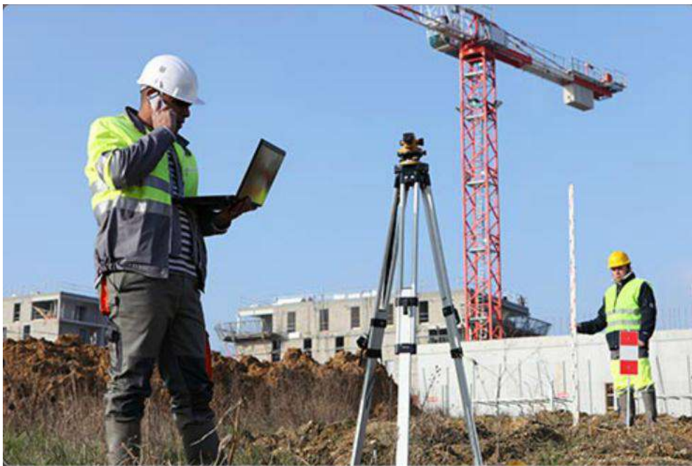
Рис. 5.39 Використання ПК на будівельних майданчиках
